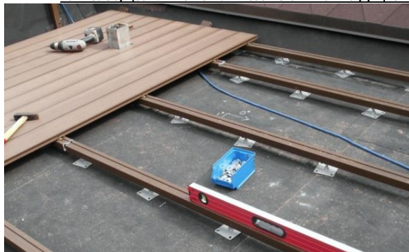
Рис.2 Укладка террасной доски на регулируемые опоры
